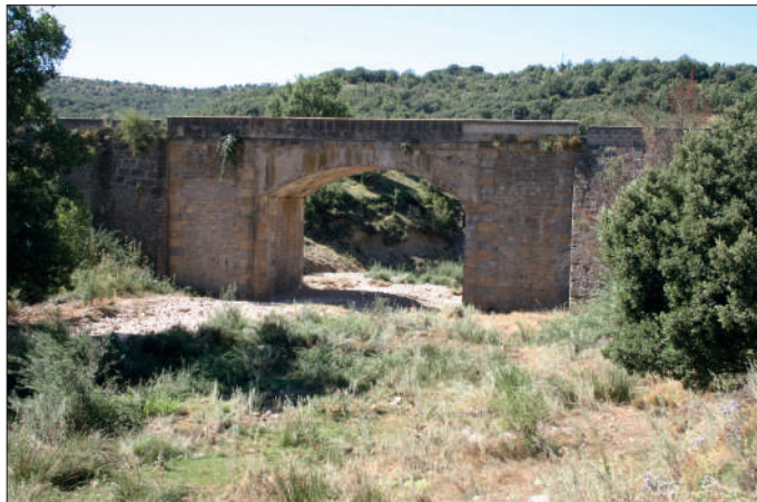
Pont de Taules, detalls de l'estrep i el contrafort. A baix, perfil
