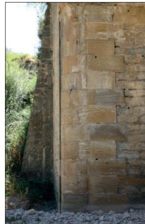
Pont de Taules, detalls de l'estrep i el contrafort. A baix, perfil
